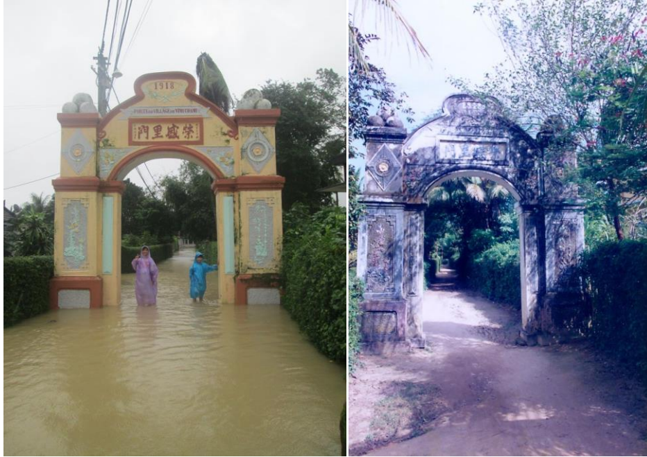
H 7, 8: Quang cảnh Lý Môn trong mùa bão lụt, và khi nước rút để lại vết mặt đường bị xói lở.
