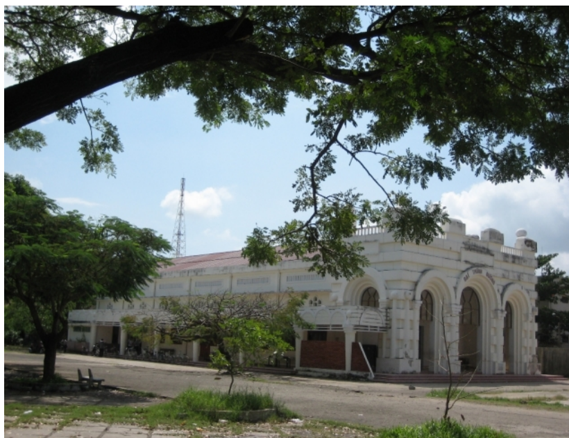
H 15: Đại thánh đường được xây cất năm 1965. (Ảnh từ Cuongde.org)
